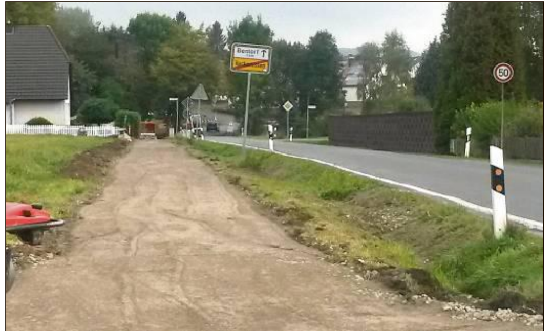
Die Bauarbeiten für den Bürgerradweg zwischen Bentorf und Harkemissen haben begonnen.
